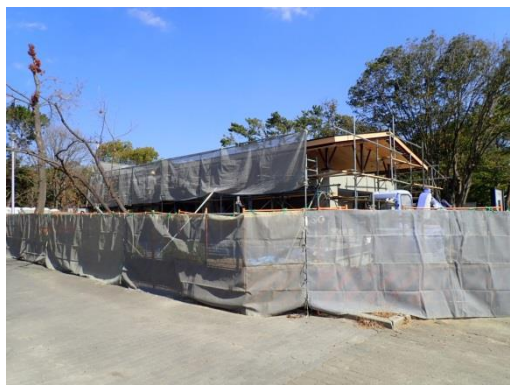
2番トイレ（バーベキュー広場前）改修の様子
